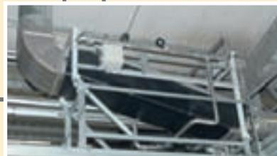
Kondensationswärmetauscher mit einer Leistung von 250 kW.
