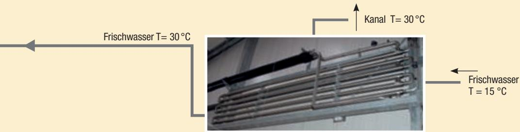
**Der Rohr-in-Rohr-Wärmetauscher, Leistung 300 kW.**
