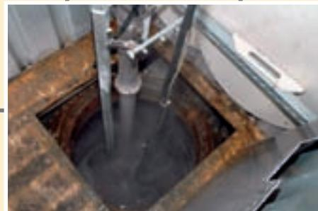
**In einem Becken wird das Abwasser der Waschstraßen und Waschschleudermaschinen gesammelt und mit einer Tauchpumpe in den Wärmetauscher geleitet.**
