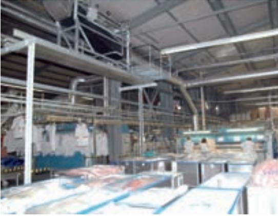
**Blick in die Wäscherei: Oben kann man den Kondensationswärmetauscher erkennen.**
